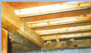
■床下換気を行った健全な床下
